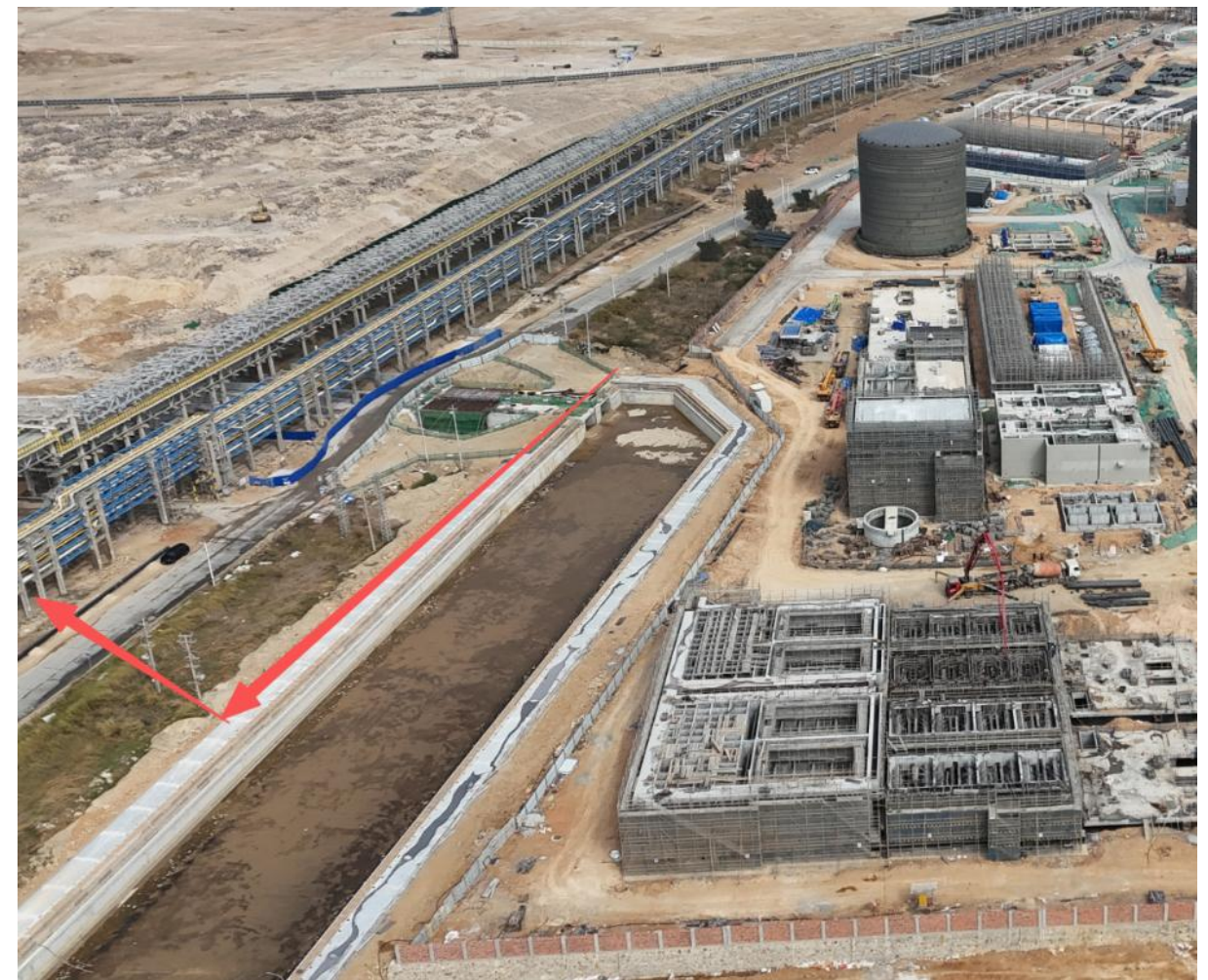
图 2.2-4 涉路管道与公路现状图
